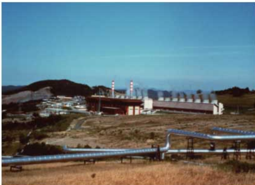
Figura 8. La centrale geotermica da 120 MWe, Valle Secolo, nell'area di Larderello.
